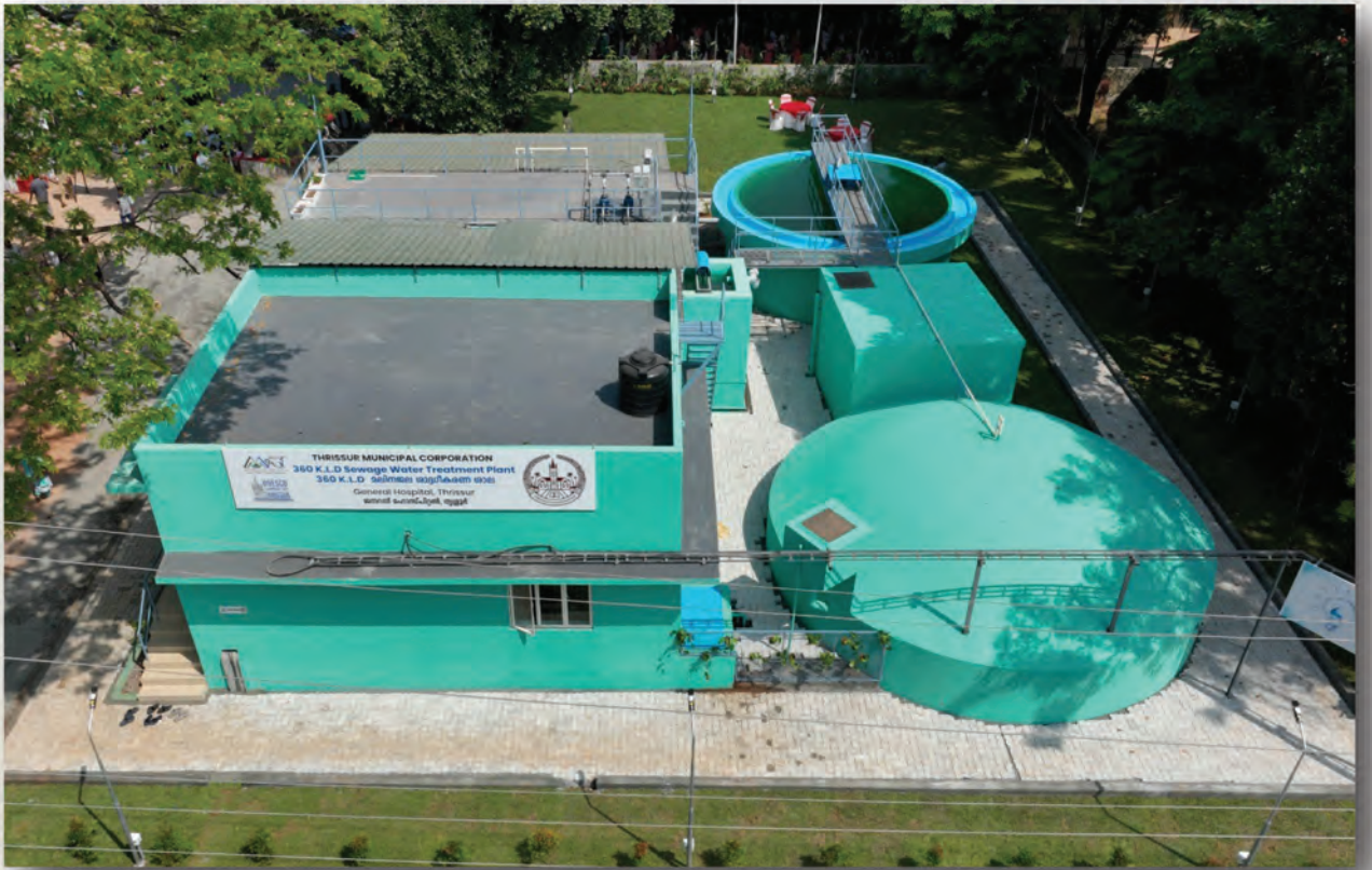
അമൃത് പദ്ധതിയിൽ ഉൾപ്പെടുത്തി തൃശ്ശൂർ ജനറൽ ഹോസ്പിറ്റലിൽ സ്ഥാപിച്ചിരിക്കുന്ന 360 കെ.എൽ.ഡി. ശേഷിയുള്ള ദ്രവ മാലിന്യ സംസ്കരണ പ്ലാന്റ്
