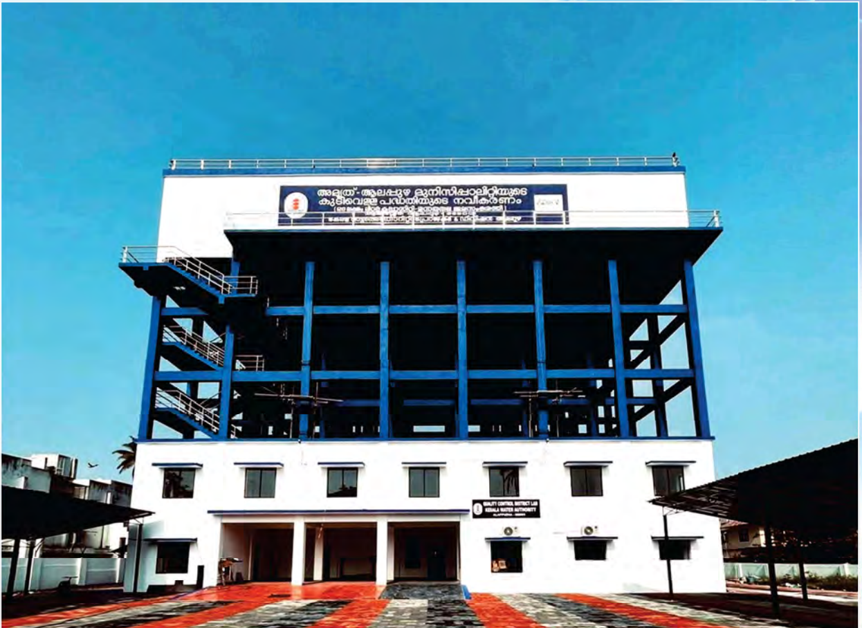
ആലപ്പുഴയിൽ നിർമ്മാണം പൂർത്തിയാക്കിയ ഓവർ ഹെഡ് ടാങ്ക്
